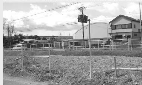
豊川市諏訪県営住宅横の佐奈川河川補修工事
