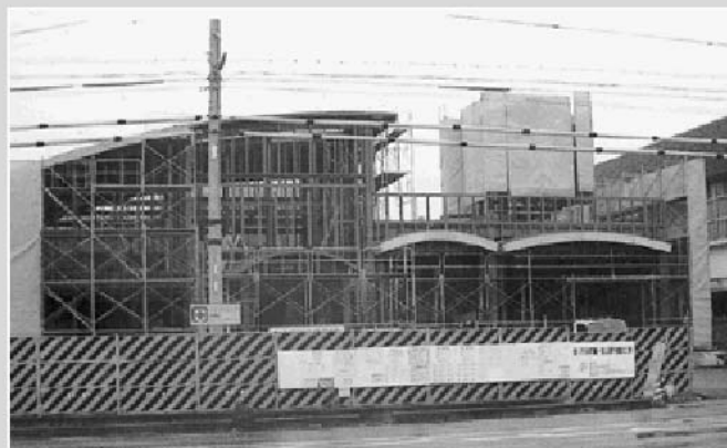
消防署一宮出張所の建設工事に着手
