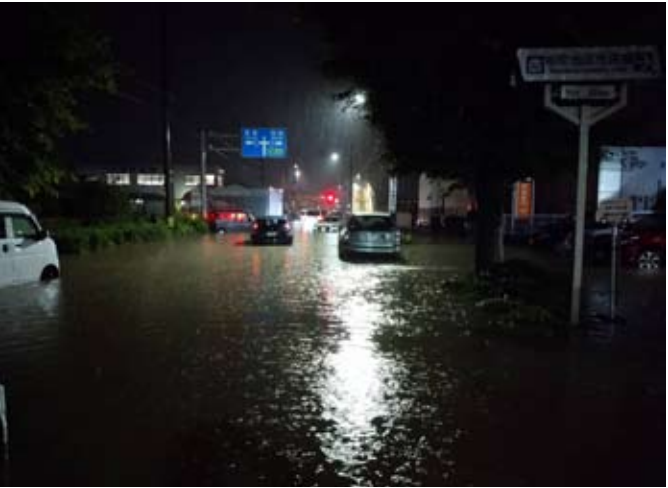
冠水した桜町地区市民館前の県道
