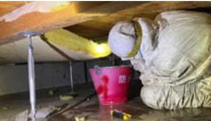
床下に潜って断熱材を撤去
