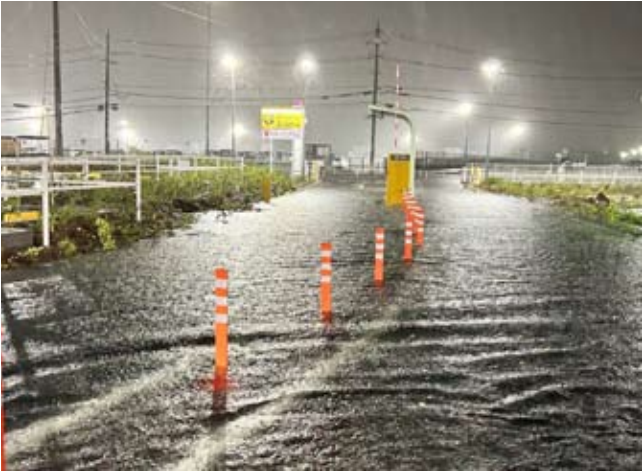
敷地内の道路も冠水
