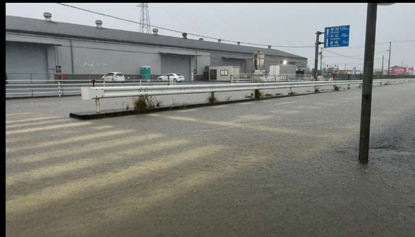
6月2日午後、冠水した国道1号「京次」交差点
