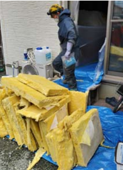
床下から運び出された断熱材
