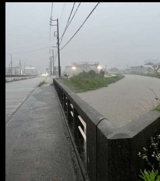
水位が上昇した西古瀬川（国道1号の橋付近）
