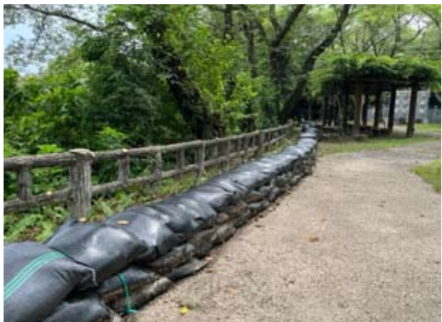
土のうで雨水の流出を防ぐ措置が取られた御津山園地
