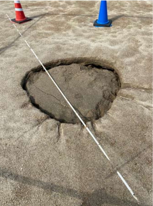
運動場では陥没が発生した
