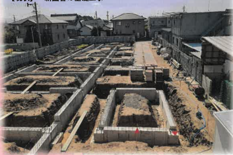
【現状】新園舎の基礎工事
