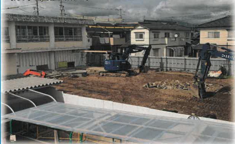
【完了】南園舎の解体工事
